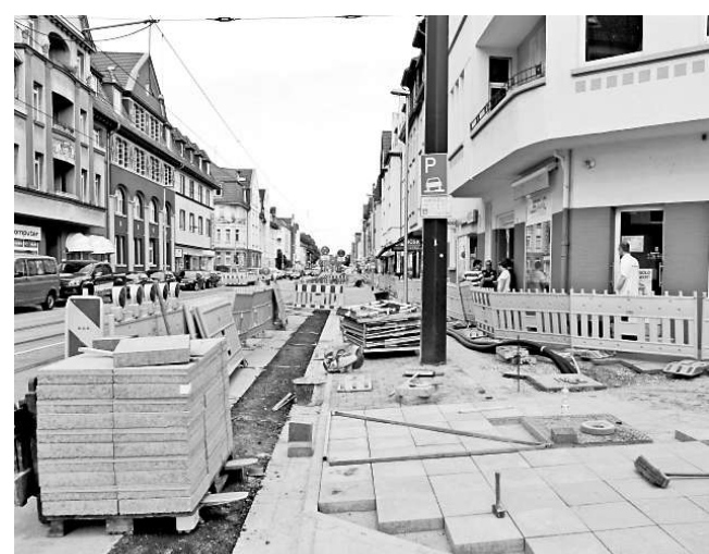
BAUSTELLE: Am Ricklinger Stadtweg wird zwischen Höpferstraße und Nordfeldstraße der Fußweg erneuert. Foto: Dröse
